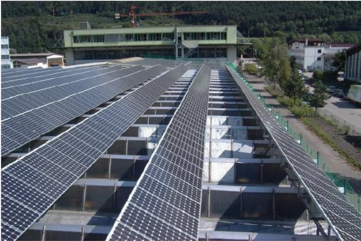
Figura 35 – Foto da cobertura de um empreendimento e placas fotovoltaicas. Energyteambrasil (2012).
